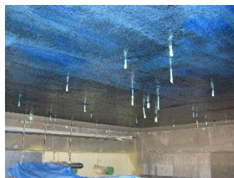
スラブ下面補強
