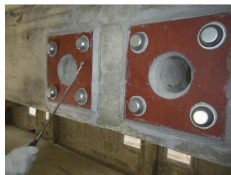
梁貫通孔補強
