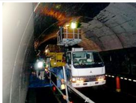
トンネル補強工事
