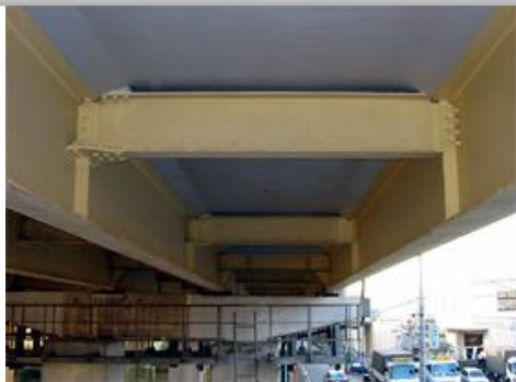
床版補強工事
