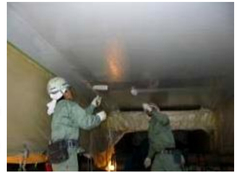
HiPerCF 工法 施工状況
